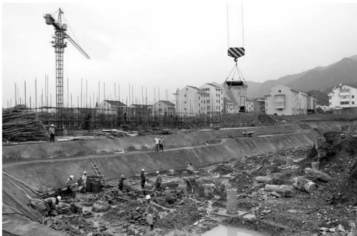
▲昨日,记者在市公租房建设现场看到,该项目进展顺利。据了解,市公租房工程分首期和二期,首期总建筑面积为57326平方米,共667套住房,目前已完成桩基工程,启动多层基础工程和高层基坑围护工程;二期正在设计施工,已启动施工与监理招标,开始进场填土。 张玉萍摄
