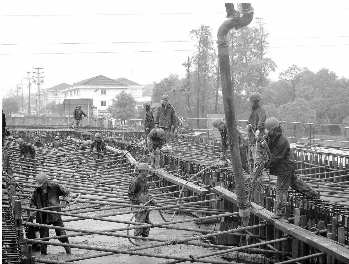
昨日,正在施工中的柏叶路洛河大桥进入箱梁浇筑阶段。据了解,此次浇筑的是大桥左半幅箱梁底板,全长156米,宽21米,预计5月底前完成左半幅箱梁的整体浇筑工作。徐希 郑家军摄
