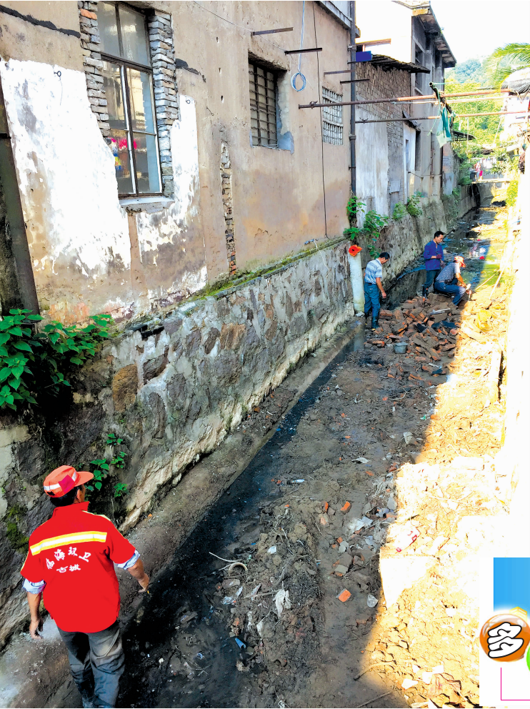
古城街道在整治清理了 25 条江边河道的基础上,将“五水共治”的重心移至整治村级狭小的阴沟窄缝处。由于阴沟狭窄无法用大型机械进行清理,连日来,该街道集中精力,发动社区工作人员和部分村民及环卫工人,采用小型翻斗车和人工手挖的方式,对后山村水磨坑至东大河这条长达千余米的阴沟窄缝进行全面清理。
