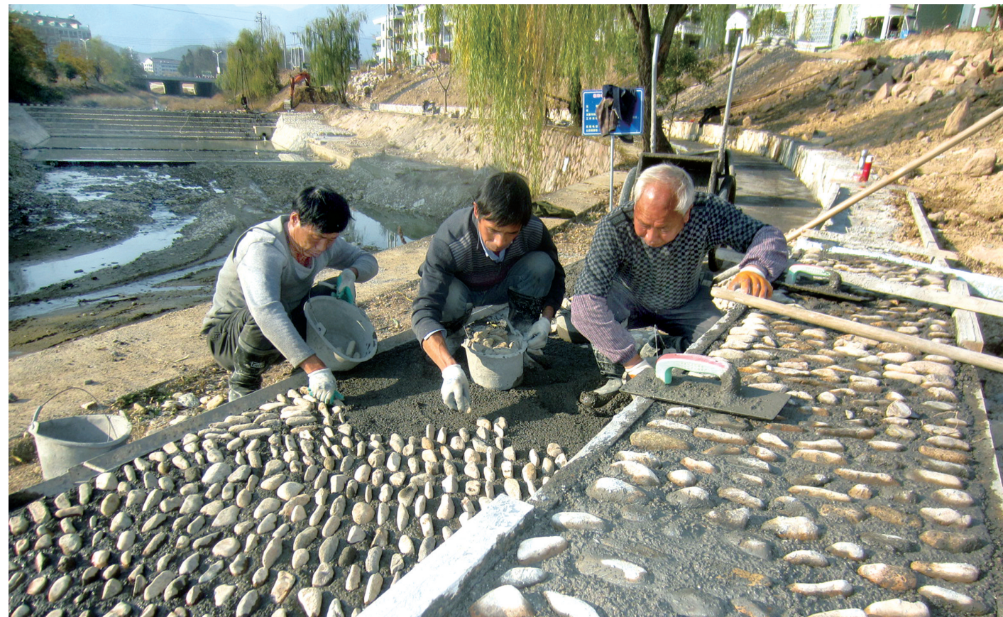
昨日,白水洋镇双港溪流域综合治理一期工程黄沙溪镇区段工地,工人们正在忙着铺设1.8千米的游步道。黄沙溪镇区段工程包括河道整治、溪岸绿化和漫步道建设等项目,总投资712万元,目前已完成总工程量的90%。该工程竣工后,将为该镇的南窗口添上一道靓丽的风景线。
