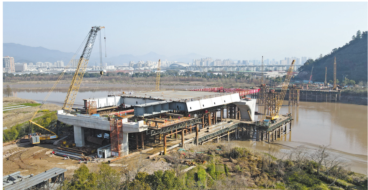
在伏龙大桥工程施工现场，一台大型履带式吊车正将一块长16米、高3.8米、宽2.35米，重达41吨的钢箱梁块体平稳起吊就位至南岸拼装平台上。
