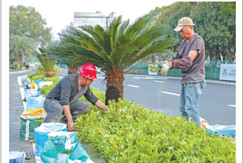
近日，市住房和城乡建设局的施工人员在市区开发大道北侧路段绿化带种植杜鹃花。
