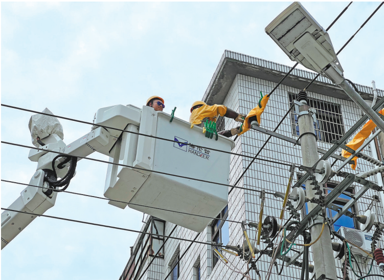
图为国网临海市供电公司带电作业班正在花街小区进行带电作业。
